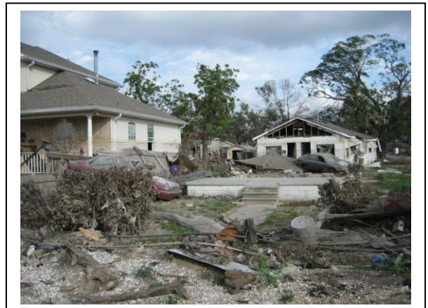
Nowy Orlean po huraganie Katrina: woda zepchnęła dom z fundamentów i przesunęła go.
