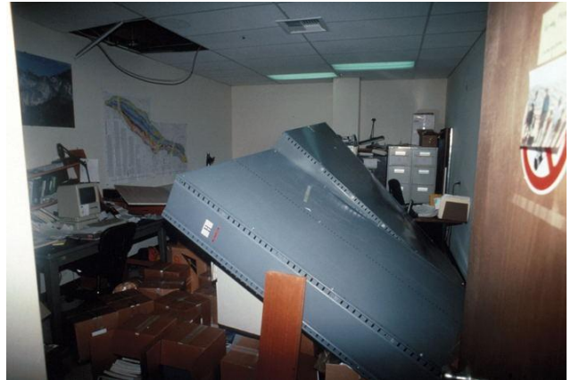
Fot. 2. Regały biblioteczne (nieprzymocowane do ściany), które przewróciły się podczas trzęsienia ziemi Loma Prieta (Oakland, Kalifornia), 17 października 1989 roku. (Źródło: US Geological Survey Photographic Library: http://libraryphoto.cr.usgs.gov Slide VI-1 USGS Open File Report 90-547).
