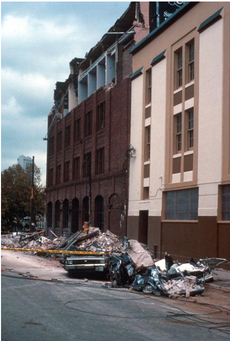
Fot. 1. Samochody zmiażdżone przez spadające fragmenty budynku. Pod gruzami zginęło pięciu ludzi wyjeżdżających właśnie z pracy. Trzęsienie ziemi Loma Prieta (Oakland, Kalifornia), 17 października 1989 roku. (Źródło: US Geological Survey Photographic Library: http://libraryphoto.cr.usgs.gov Slide 1-1 USGS Open File Report 90-547).
