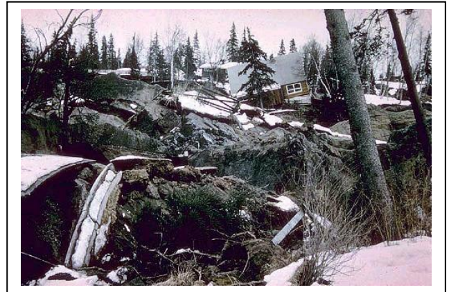
Fot. 2. Budynki uniesione razem z osuwiskiem. Osuwisko Turnagain Heights w Anchorage (Alaska). 75 domów zapadło się, obróciło lub zawałiło gdy upłynnienie gruntu wywołane trzęsieniem ziemi o magnitudzie 9,2 spowodowało w 1964 roku jego osunięcie o prawie 700 metrów. Zdjęcie z archiwum Earth science World Image Bank ( http://www.earthscienceworld.org/images/index.html ). ID: hfyyxn. National Geophysical Data Center.
