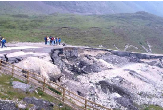
Fot. 2. Mam Tor – dawna droga, poważnie uszkodzona na skutek osunięcia ziemi, nieprzejezdna od 1977 roku. (Fotografie: Peter Kennett)
