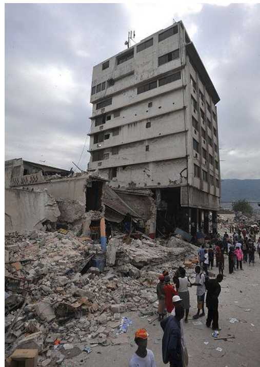
Fot. 3. Zniszczone budynki w Bel-Air, dzielnicy slumsów w Port-au-Prince (Haiti), po trzęsieniu ziemi w 2010 roku. Wysoki budynek stoi samotnie w morzu ruin mniejszych budynków, zbudowanych mniej solidnie.
