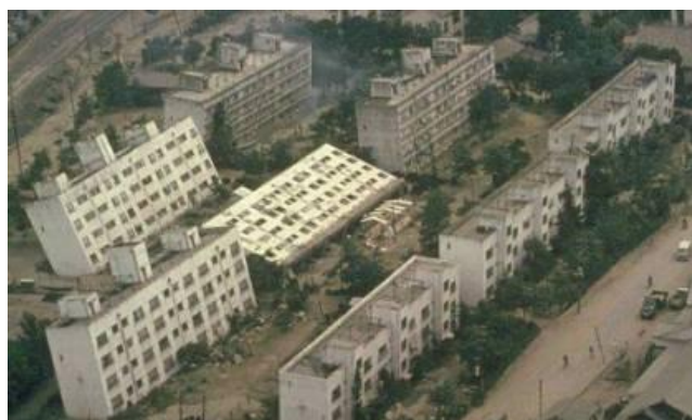
Fot. 2. Oto co trzęsienie ziemi potrafi zrobić z budynkami posadowionymi na niespoistym gruncie.
